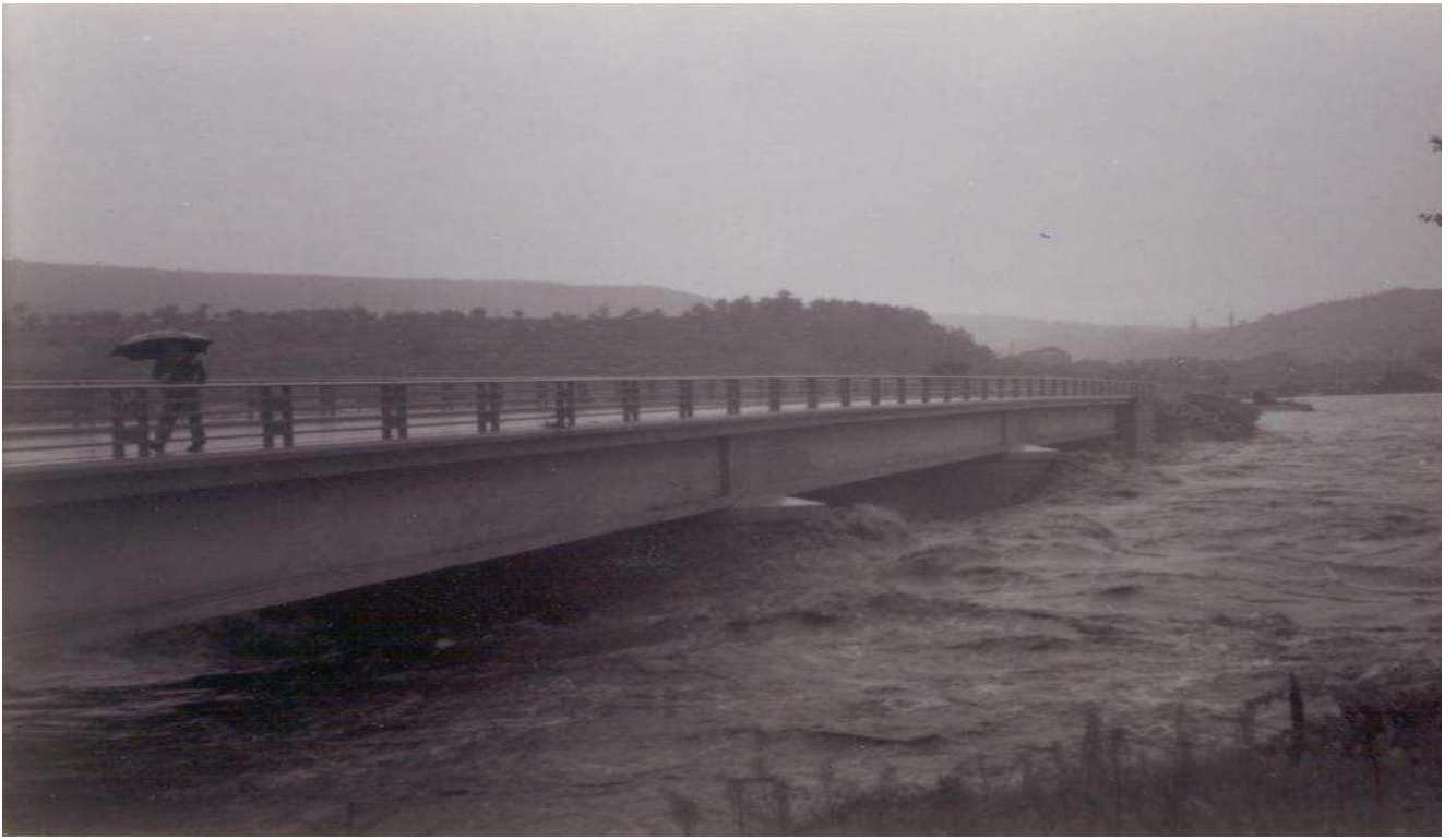
Crue octobre 1958 - amont pont de la Beaume
