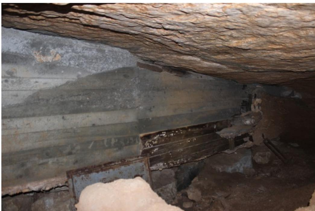
*Illustration 10: arrière du mur et espace dégagé sous le mur pouvant servir de fondations*
