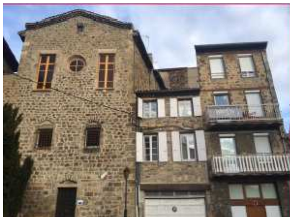
restructuration de l'îlot Musée : 4 logements démolition immeubles réalisées ; livraison prévue 2018
