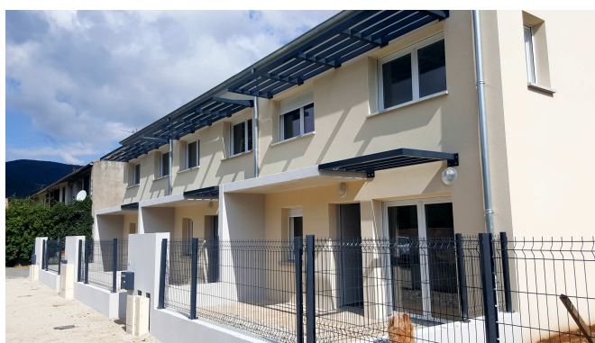
Ardèche Habitat/Construction neuve/Le Rhône à Cruas
