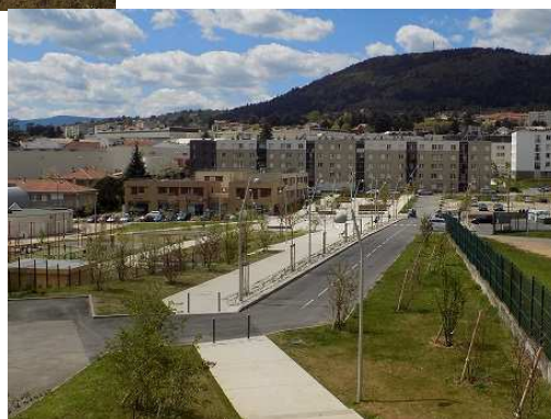
Les travaux sur les 320 logements à réhabiliter sont quasiment terminés. Seuls les travaux sur la Tour H restent à achever, pour une livraison mi-2017.
