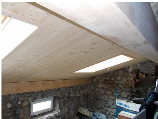
isolation sous toiture et réfection de toiture
