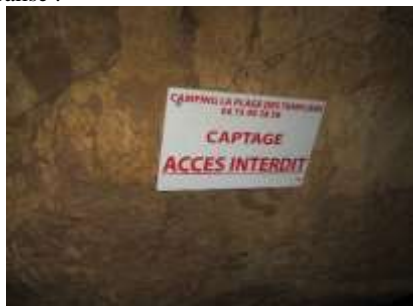
Panneau posé à l'entrée de la cavité
