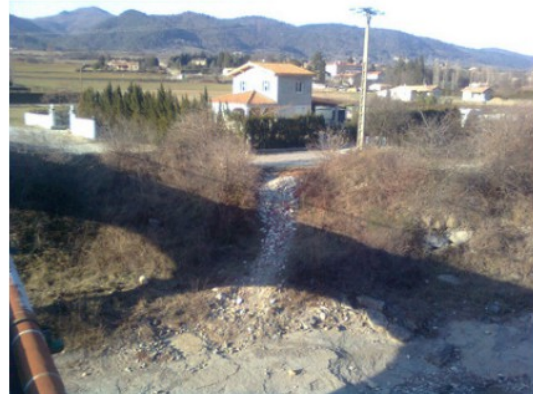
Détail de l'échancrure dans le merlon
