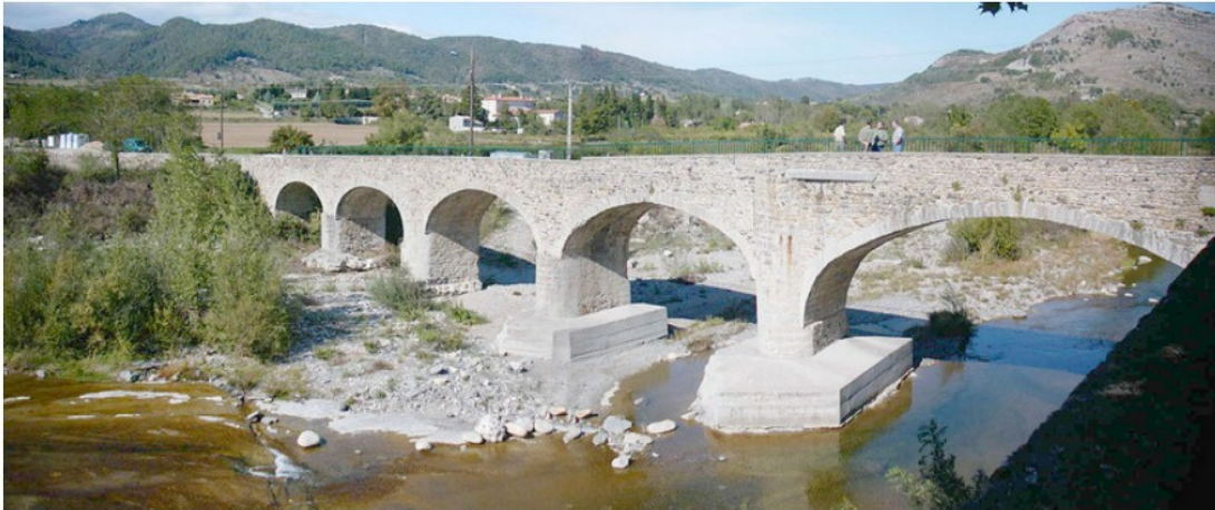
Le pont des Celliers
