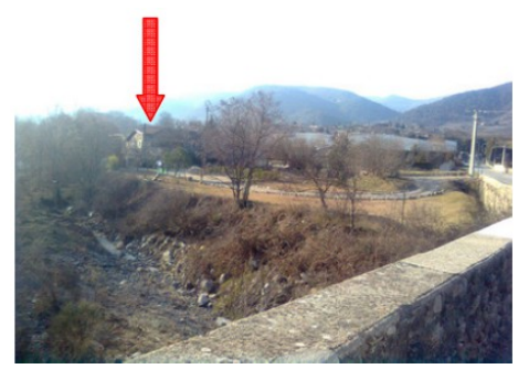
Extrémité aval de la digue de la Teinture prolongée par un merlon
