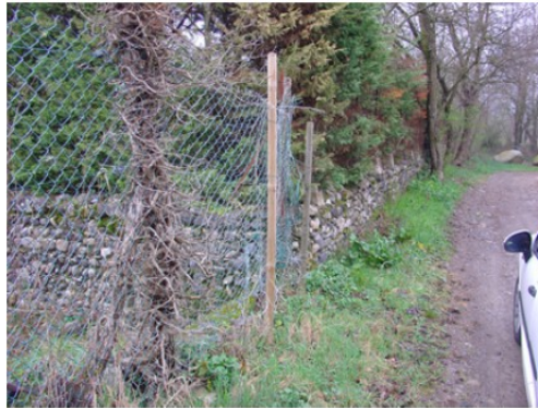
Mur du camping de l'Albanou
