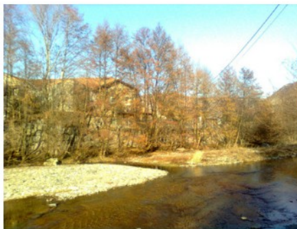
Extrémité aval de la digue de la Teinture prolongée par des enrochements
