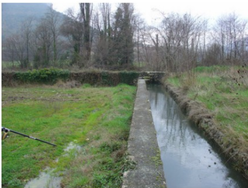
Digue des Espinets côté zone protégée
