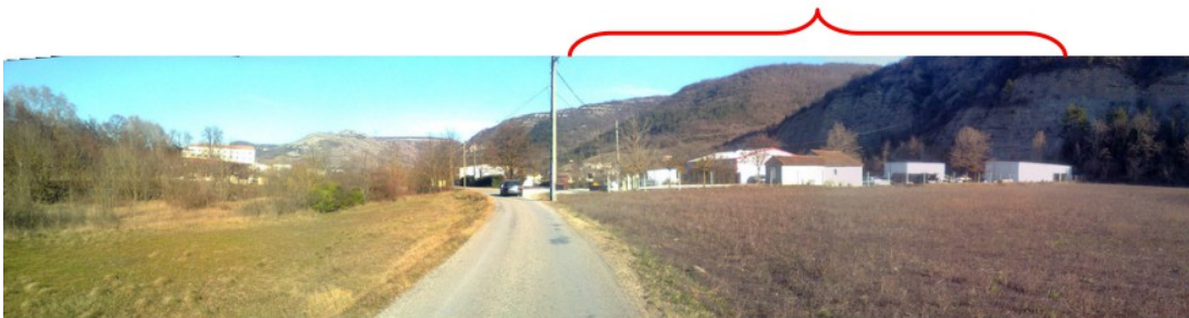
Extrémité aval du lit majeur entre le pont des Meuniers et le pont des Celliers
