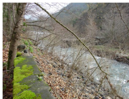
Digue en amont du seuil Payen
