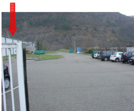
Digue de l'usine Contifibre
