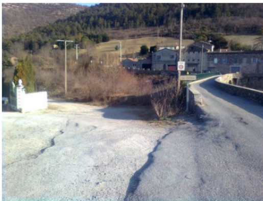
Digue en terre en rive gauche à l'aval du pont des Celliers
