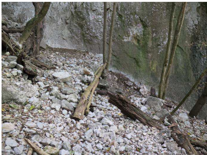
Photo 29=> aménagement d'une plateforme en pied de voie = Réemploi de troncs déracinés naturellement, parfois recoupés, et de blocs rocheux.
