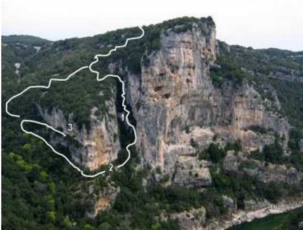
Photo 3 => vue générale et accès à la combe de la Fusée (1), au Solarium (2) et à la vire Ouest (3) depuis la parking routier du belvédère d'Autridge
