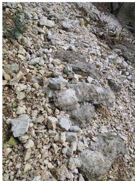
Photo 30=> Réemploi de blocs rocheux pour stabiliser le sentier.
