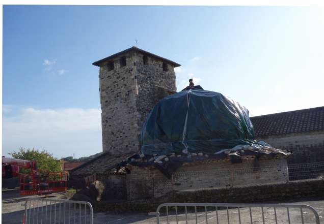
Eglise de Mélas du Teil le 18 novembre 2019 – travaux de stabilisation et de conservation
