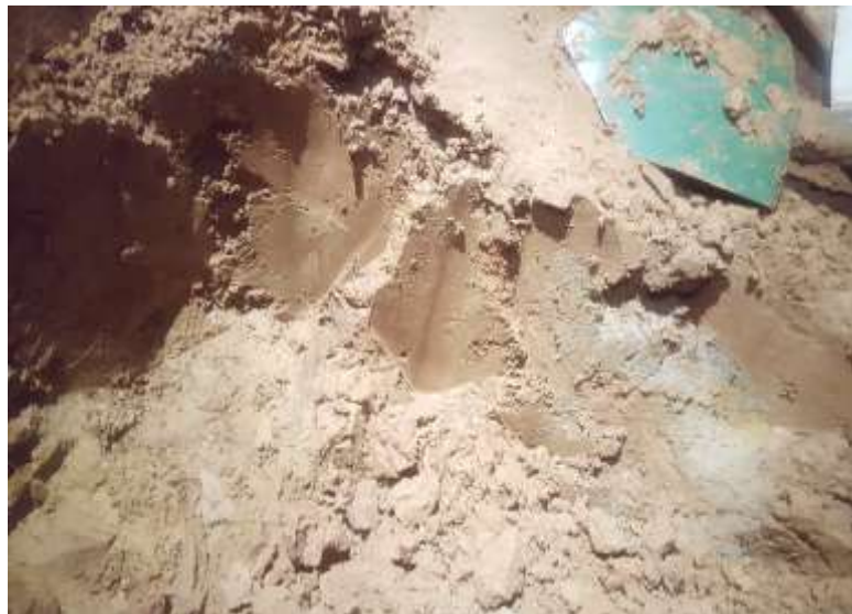
placage d'argile en première protection
