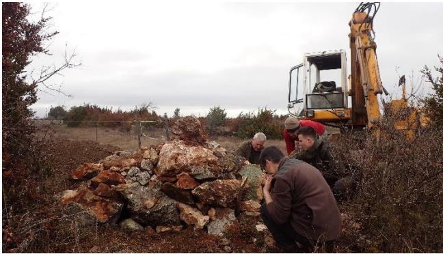
Construction d'une garenne principale avec les pierres récupérées sur le site.
