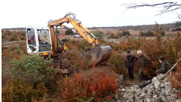
Construction des garennnes avec les chasseurs de l'ACCA à l'aide d'une pelle mécanique et des matériaux sur place (pierres et terre).
