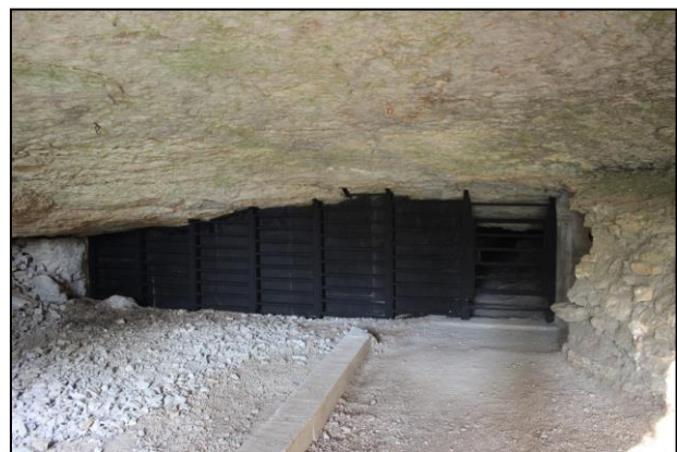
Vue après travaux
