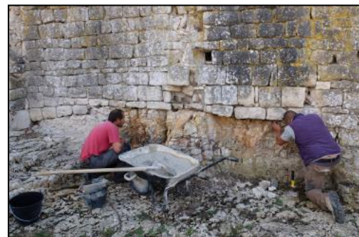
Nettoyage et jointoiment de la base du mur de l'église
