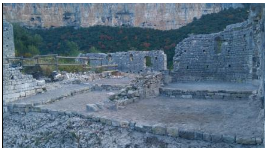
Vue générale des églises après travaux
