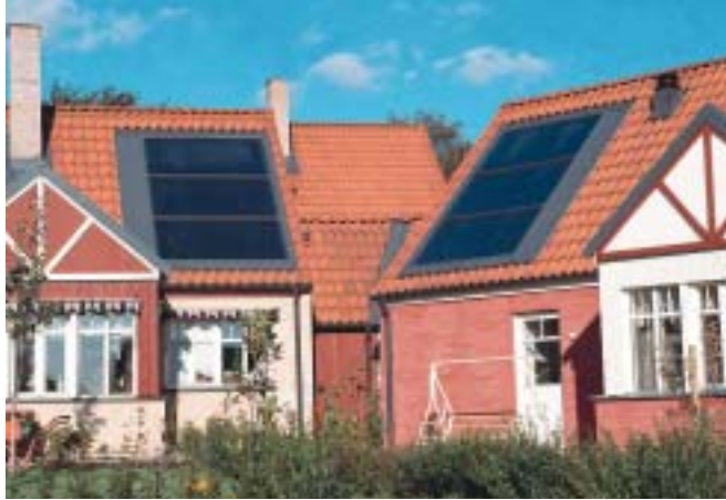
Maison individuelle en Suède : 18 m 2 de capteurs, 1 500 litres de stockage, appoint par chaudière à granulés bois.
