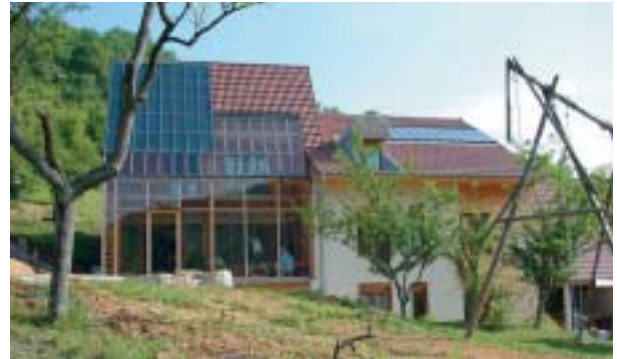
Maison individuelle à Besançon (Doubs) : 140 m 2 habitables, occupée par cinq personnes ; 16 m 2 de capteurs en toiture (avec un chauffage d'appoint séparé au bois).
