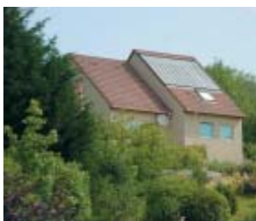
Maison individuelle à Besançon (Doubs) : 120 m 2 habitables, occupée par quatre personnes et 18 m 2 de capteurs en toiture (chauffage d'appoint intégré par chaudière électrique).
