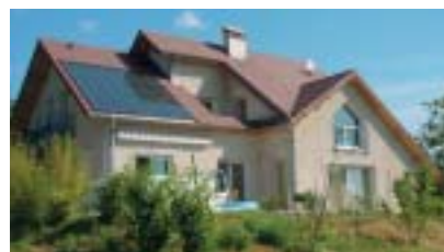
Maison individuelle dans le Doubs, 148 m 2 habitables, occupée par cinq personnes. 16 m 2 de capteurs intégrés en toiture, avec un ballon de 300l.
