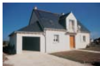
Maison individuelle en Indre-et-Loire ; PSD®, 17 m 2 de capteurs intégrés en toiture, avec un ballon de 500l.
