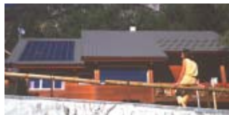
Maison individuelle dans les Hautes-Alpes ; PSD® avec capteurs occupant le tiers de la toiture.
