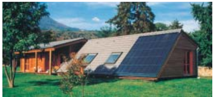
Maison individuelle à Chapareillan (Isère) : occupée par quatre personnes, 16 m 2 de capteurs en toiture (avec chauffage d'appoint couplé par chaudière fuel).
