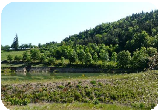
Retenue collinaire à Arlebosc
