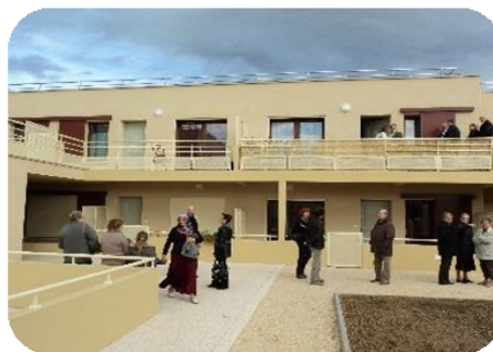
Bâtiment le Callisto : 15 logements
