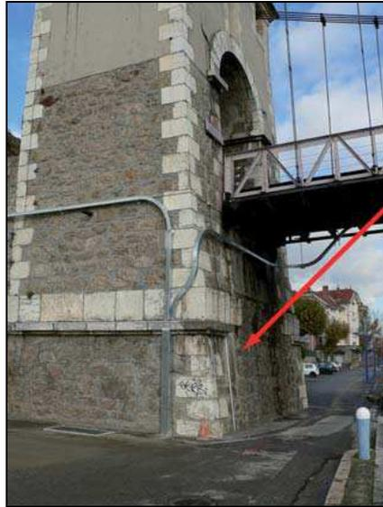
Figure 3-5 : Laisse de crue du Rhône sous le pont suspendu
