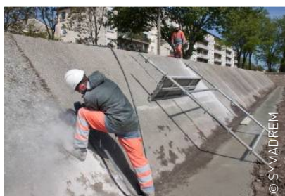
Travaux de sécurisation des digues
