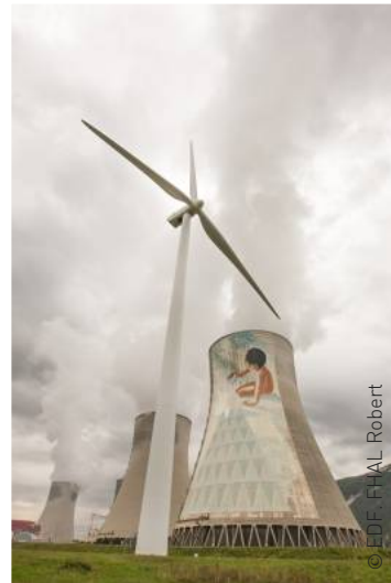
Aéroréfrigérants et éolienne à Cruas-Meysses (Ardèche)
