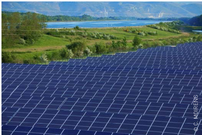
Parc photovoltaïque de Saulce-sur-Rhône (Drôme)
