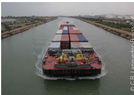
Le réaménagement du canal du Rhône à Sète : une circulation fluidifiée
