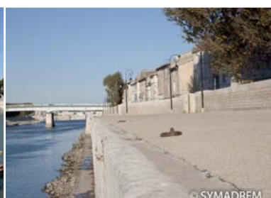
Le quai de la Roquette après travaux
