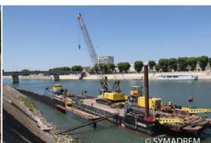
Le quai Max Dormoy pendant les travaux
