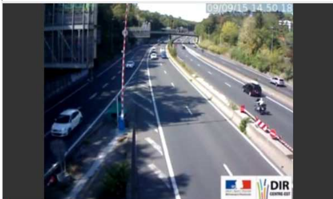
Exemple de prise de vue : A6 Vers Lyon – Sortie Valvert
